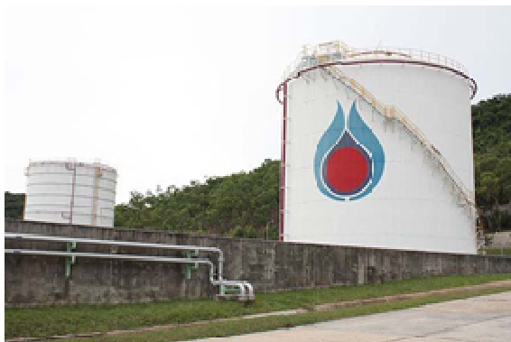
ถังเก็บก๊าซโซลีนธรรมชาติ ในถังเก็บประเภท Vertical Fixed-Roof Tank และ Internal Floating Roof Tank
