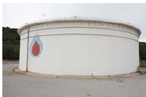
ถังเก็บน้ำมันดีเซลหมุนเร็ว ในถังเก็บประเภท External Floating Roof Tank
