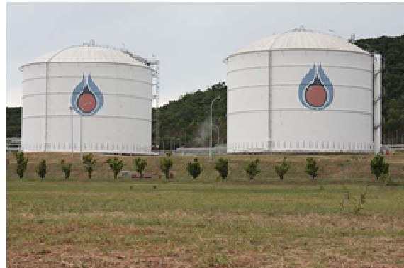
ถังเก็บก๊าซปิโตรเลียมเหลว ในถังเก็บประเภท Refrigerated Tank
